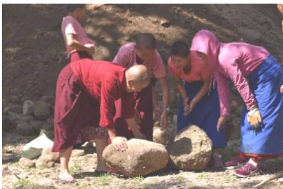
Các ni cô tiếp cận và cố gắng sửa chữa một đường ống nước bị rò rỉ—Photos: TNP
